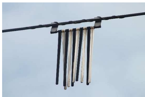
Obrázek 18: Proužkový praporek pro zviditelnění 19
