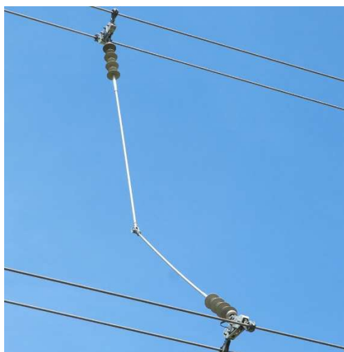
Obrázek 16: Vertikální mezifázová rozpěrka 17
